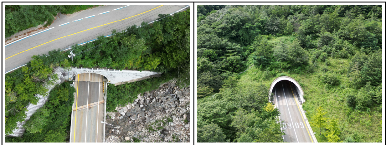
【사진 2.3.9】 사면 전경
