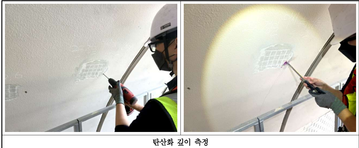
【사진 2.4.2】 탄산화 깊이 시험 현장사진
