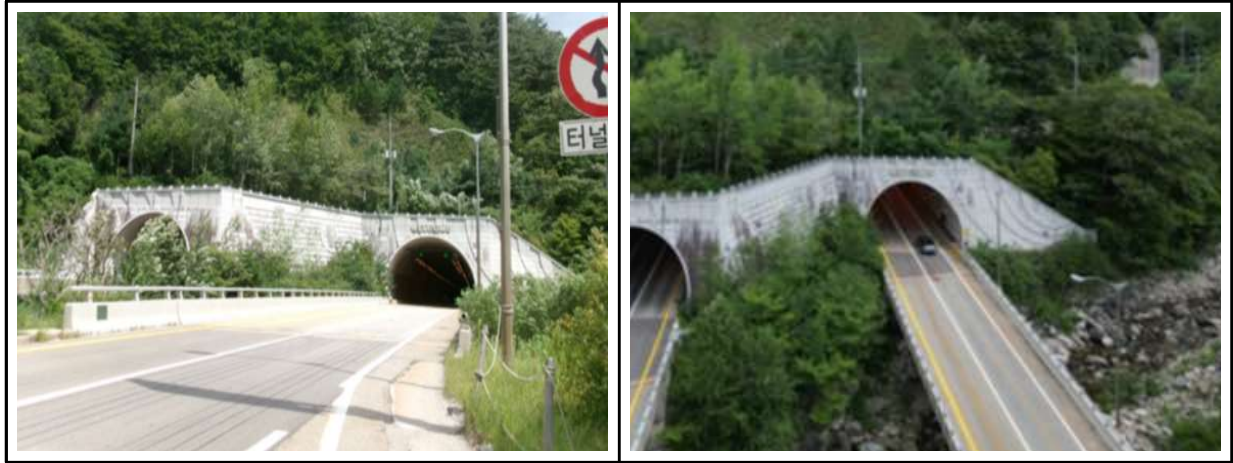
【사진 2.3.11】 옹벽 전경
