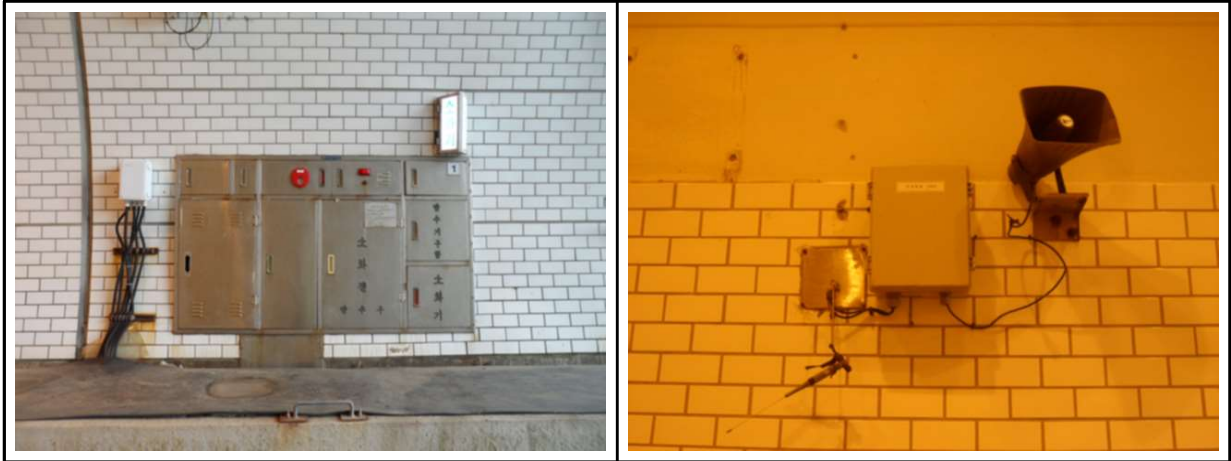
【사진 2.3.19】 기타부속시설 전경
